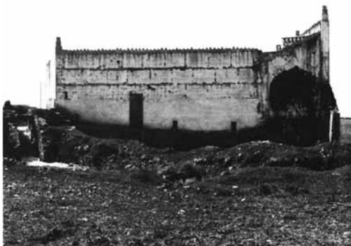
Conserva los cárcavos de entrada y salida, los puentes, el caz, el ladrón, sus muros y cubierta.
