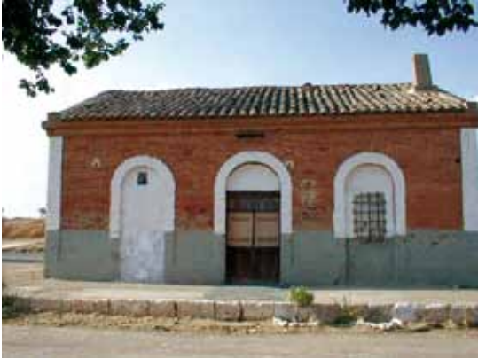
Estación del Trenillo.
