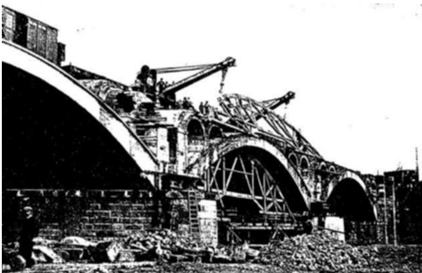
Construcción del nuevo puente del Guadalmez.
