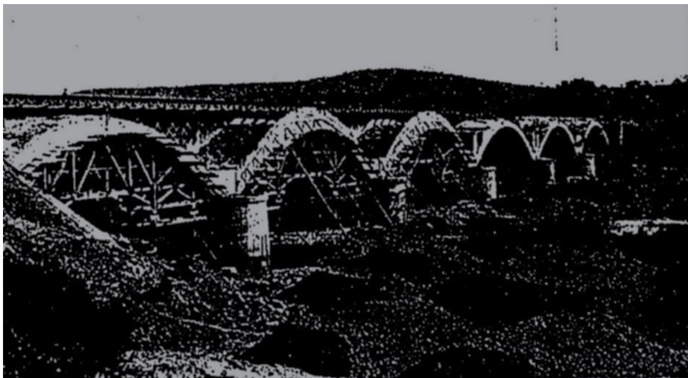
Fig. 4.ª La primera mitad del puente en construcción (29 mayo 1927).
