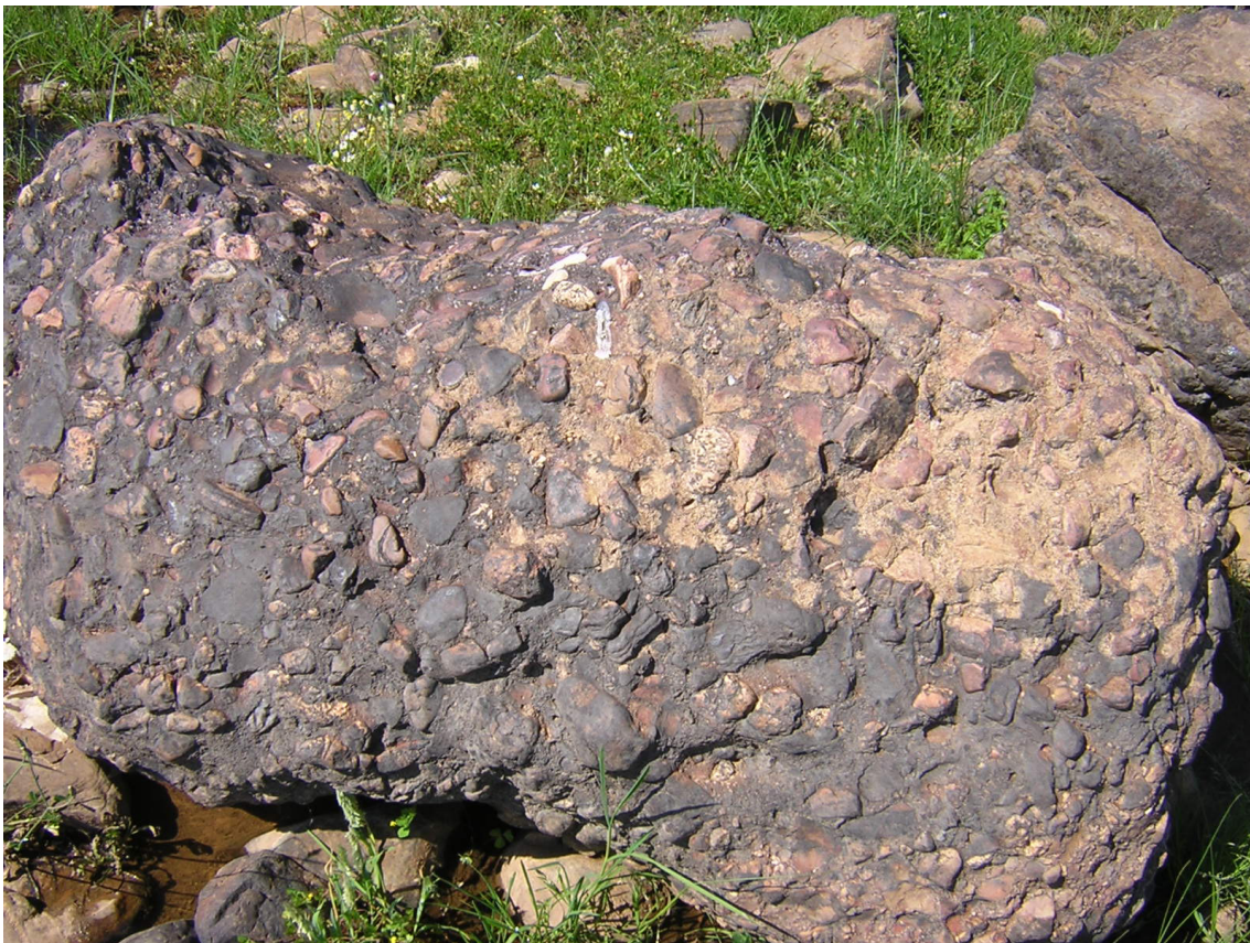
Argamasa romana del molino de la “Alcantarilla Grande”
