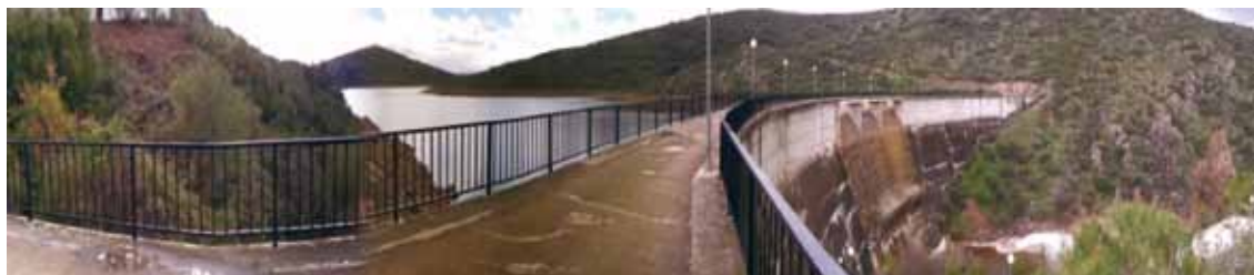
Foto panorámica de la nueva presa del Fresneda.
