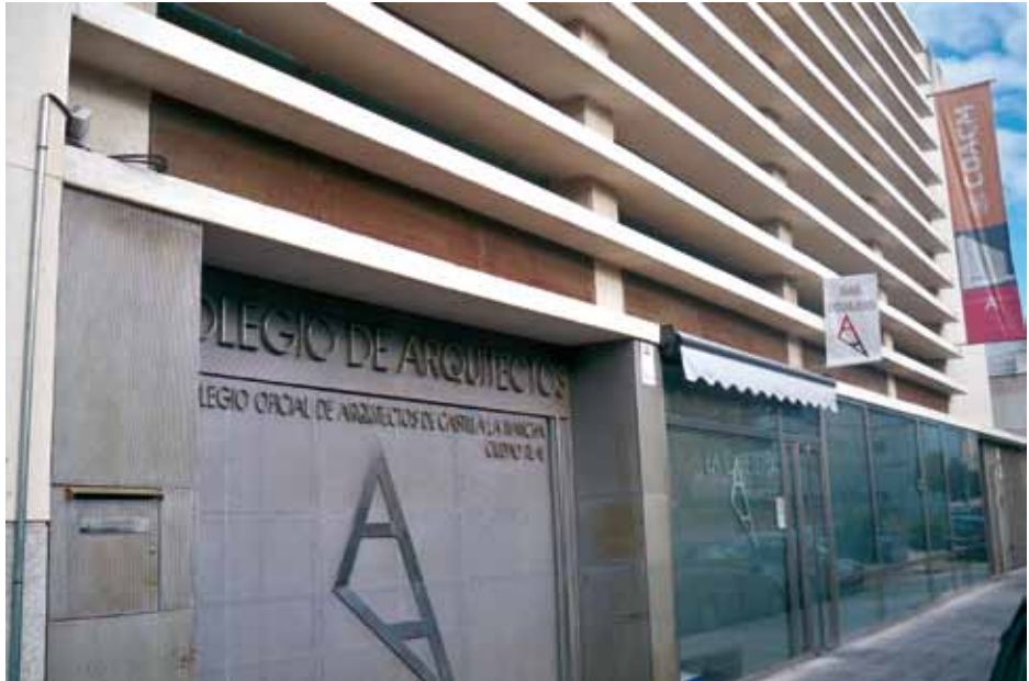
Figura 6.75.- Fachada del Colegio de Arquitectos de Ciudad Real
