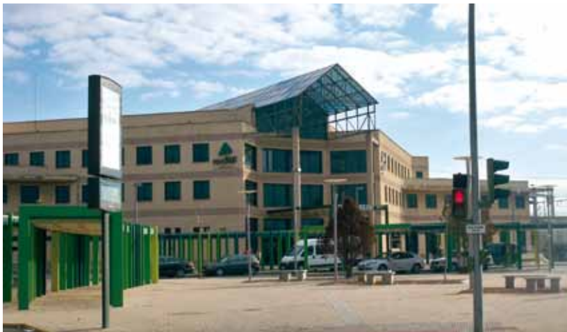
Figura 6.85.- Estación AVE en Ciudad Real
